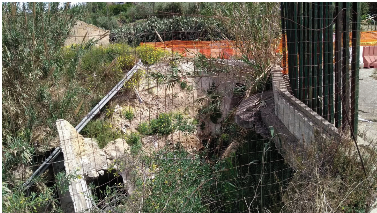
(foto 3) – parte del collettore di reflui coinvolto dal movimento
